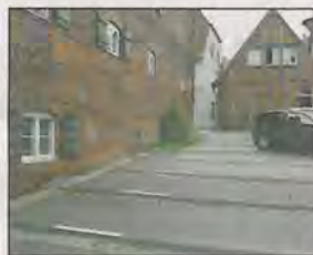
Eine Lösung mit einfachen Mitteln: Die Stufen neben dem Speicher Lücken (VHS) am Winklersgang wurden mit weißen Streifen auch für sehbehinderte Menschen besser erkennbar gemacht.
